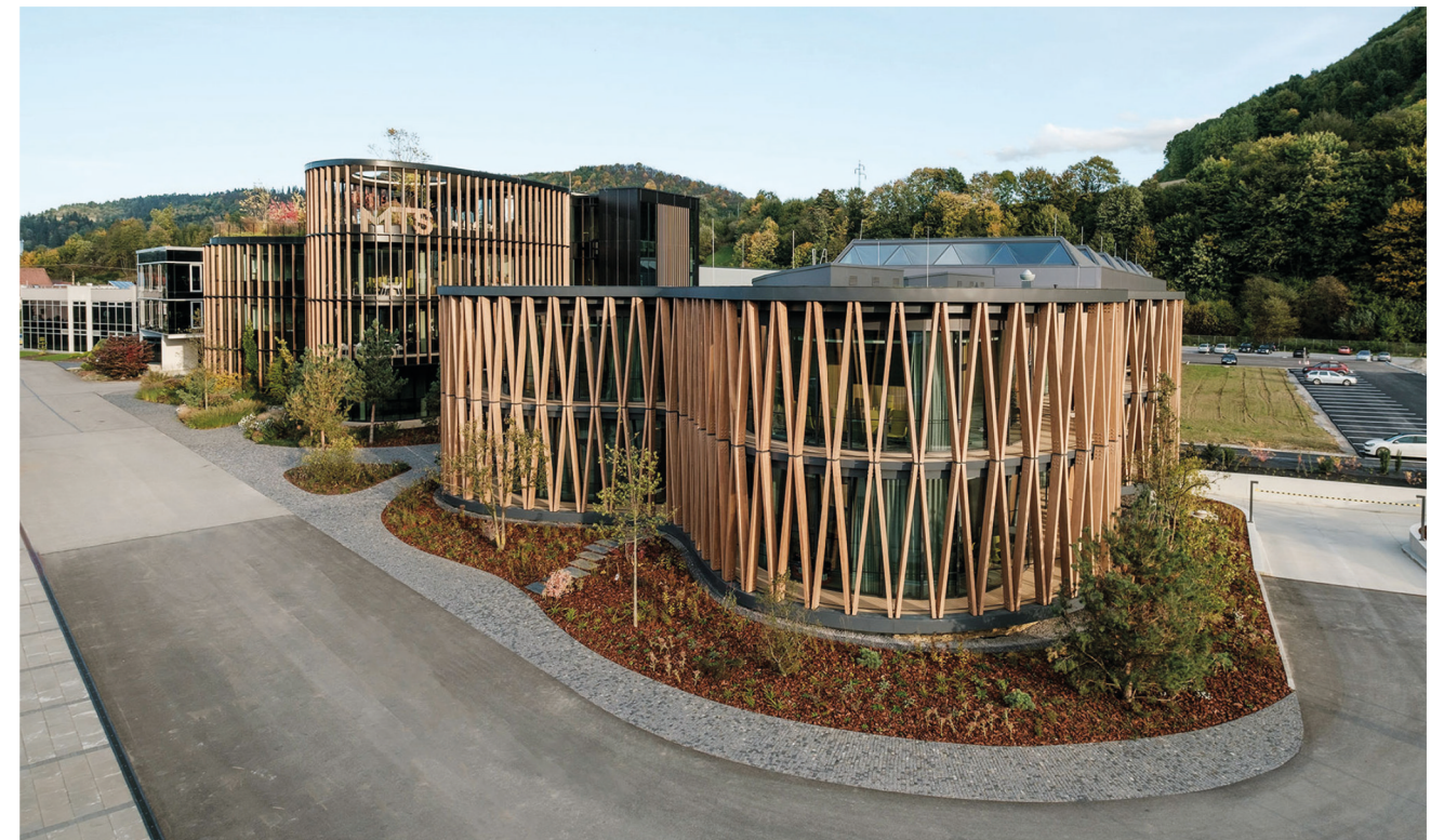
Kancelárska a výrobná budova MTSH4 Zdroj: FORMA21
